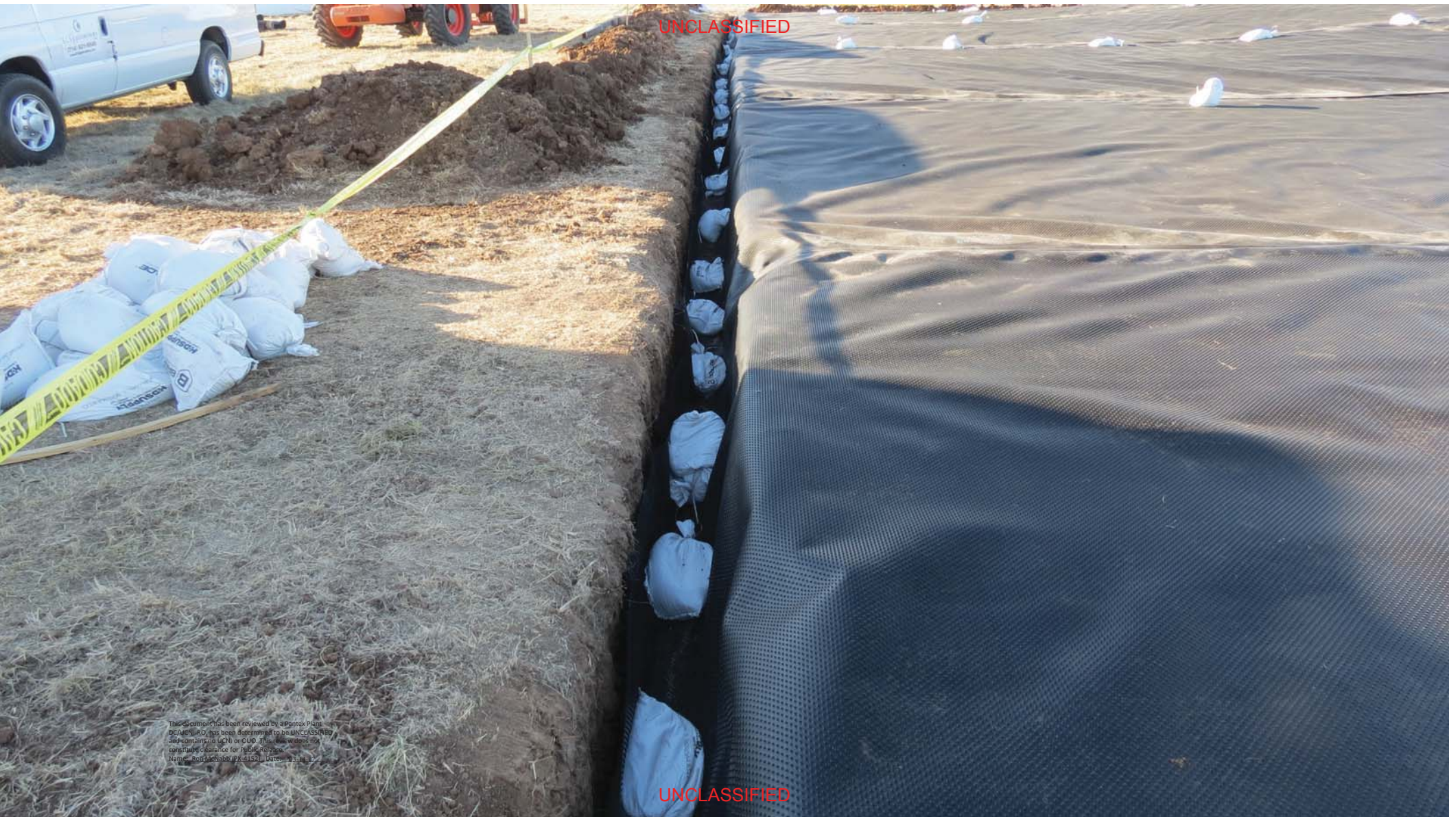
Geomembrane in Anchor Trench
