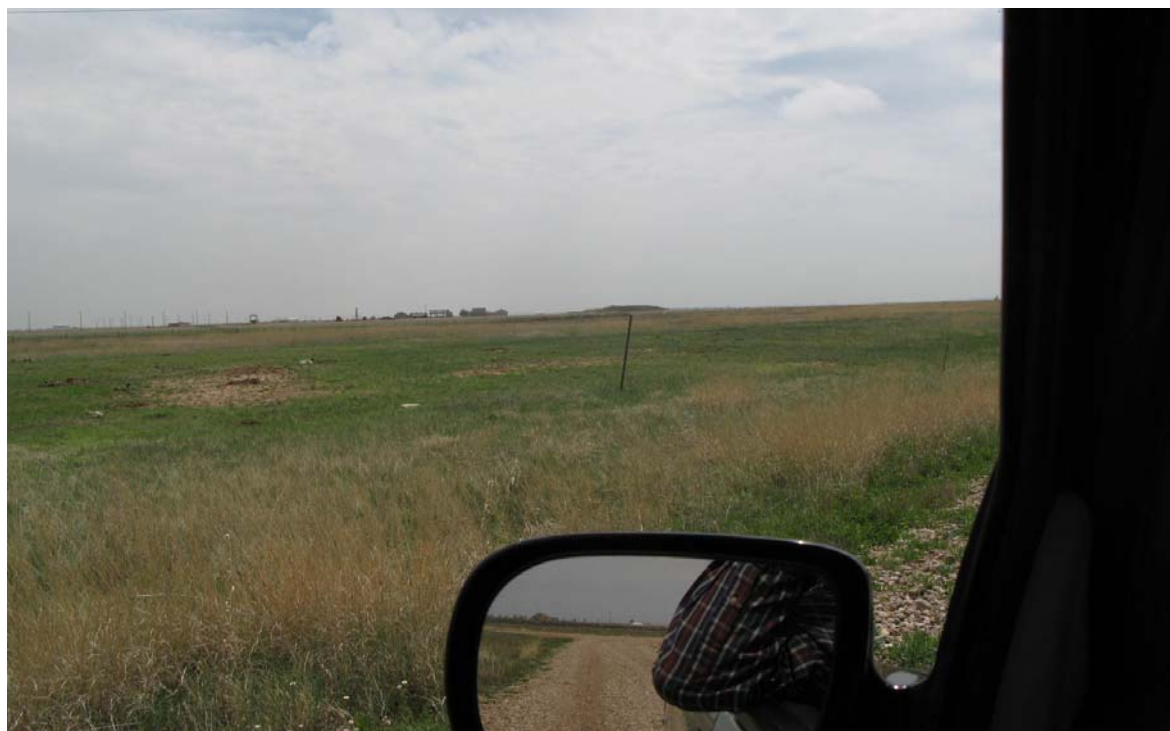
Landfill 15 (SWMU 66) Cover
